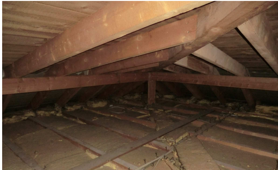
Abbildung 9 Dachstuhl von Gebäude 2
