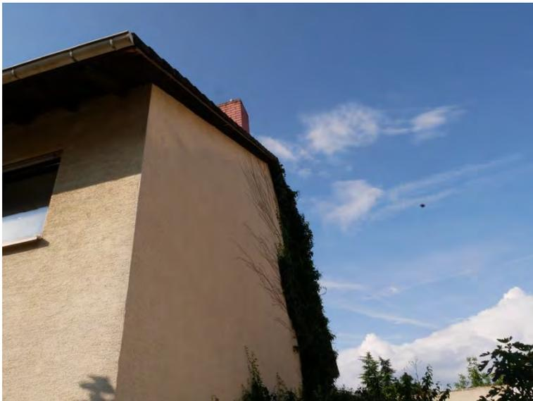
Abbildung 12: Kontrolle Fassade und Dachüberstände, Fensterbretter mit Fernglas
