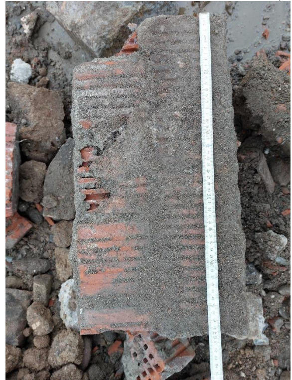
Abb. 5 Detail: Abbruch einer Ziegelwand
