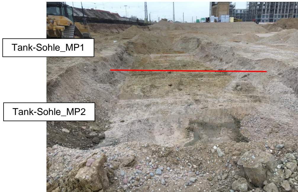
Abb. 4-2 Blick auf die Sohle der rückgebauten Betonwanne mit den Entnahmebereichen der beiden Mischproben.
