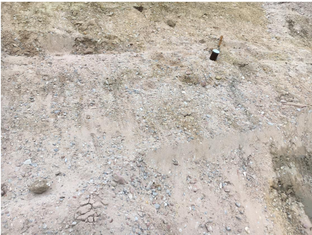
Abb. 4-3 Blick auf die sensorisch unauffälligen Neckarsedimente in der Baugrubensohle.
