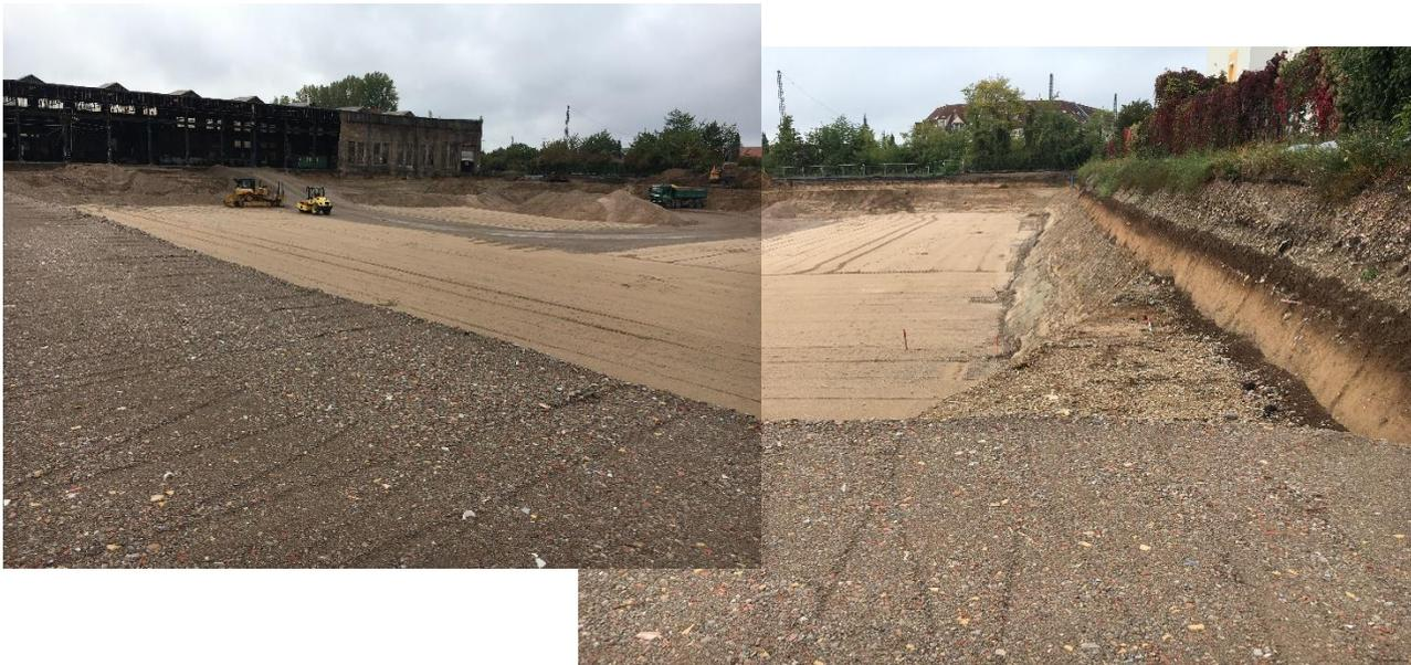
**Abb. 4-2** Blick aus NO über die Baugrube nach Erreichen des Planums; im Hintergrund verläuft die Baustraße und es lagern noch Haufwerke zur Abfuhr.
