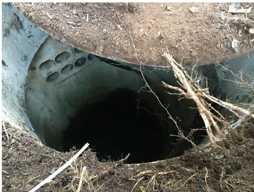
Abb. 1 Blick in den Schacht mit Metallabdeckung, Leerrohr und Leitung.
