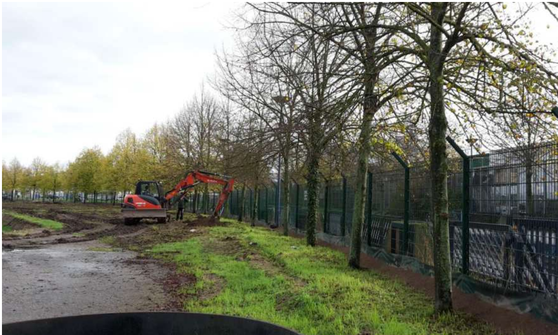
Abb. 1 Blick auf die Baumreihe in Richtung Osten
