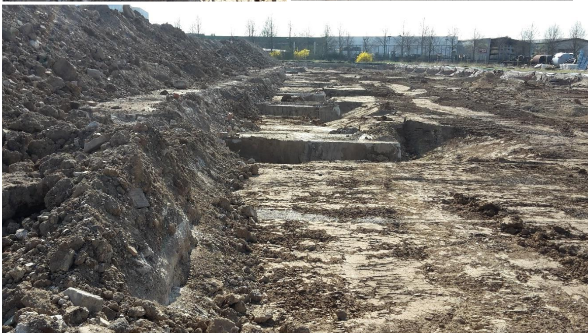
Abb. 3 a-c Fundamente der Kranbahnen
