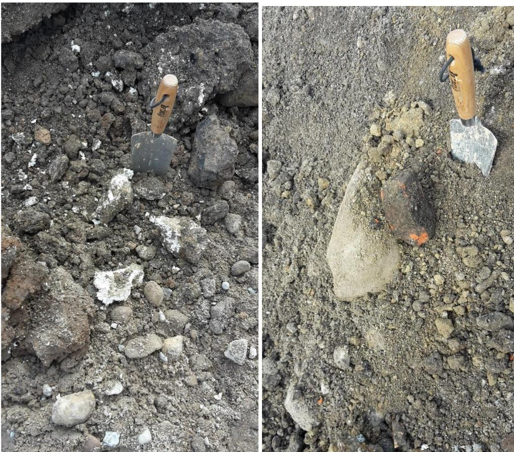
Abb.1 Detailbild der Auffüllungen unterhalb der Bodenplatten, aus S 5.
