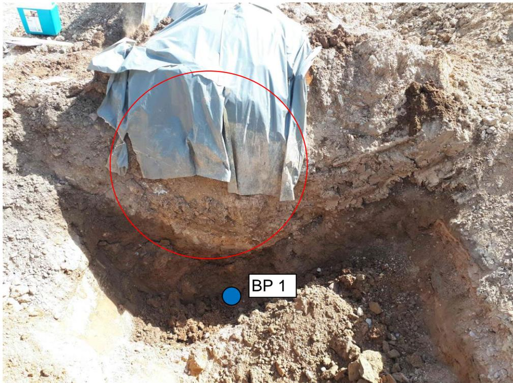
**Abbildung 1:** Blick auf das Kopfende des Tanks und in den angelegten Schurf. Der Tank ist mit einer Plane abgedeckt. Der rote Kreis zeigt ungefähr die Lage des Tanks.
