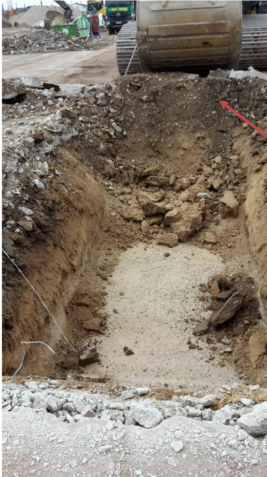
Abb. 1 Blick in Schurf S 8: Auffüllung + Lehm.
