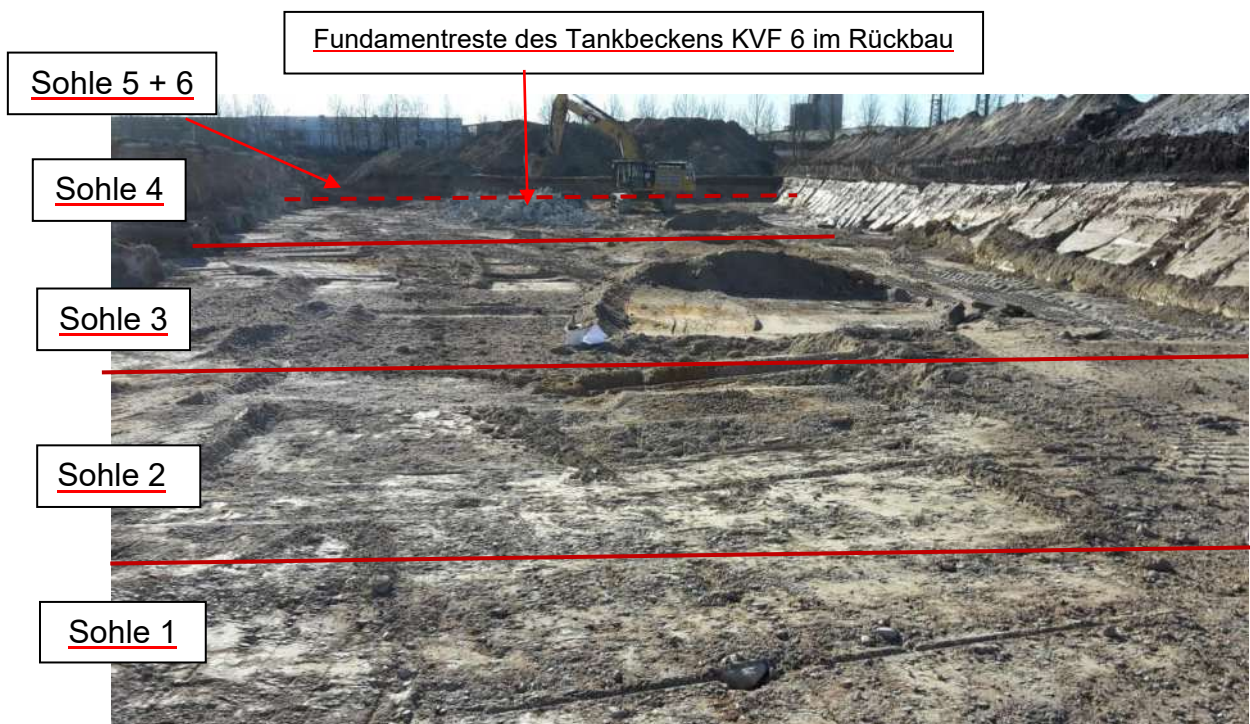
Abb. 4-1 Blick über die Beweissicherungsfläche auf die Beprobungsfelder in BA 2_West und den Tankbeckenrückbau im Hintergrund, aus nördlicher Richtung, Stand 27.02.2023.
