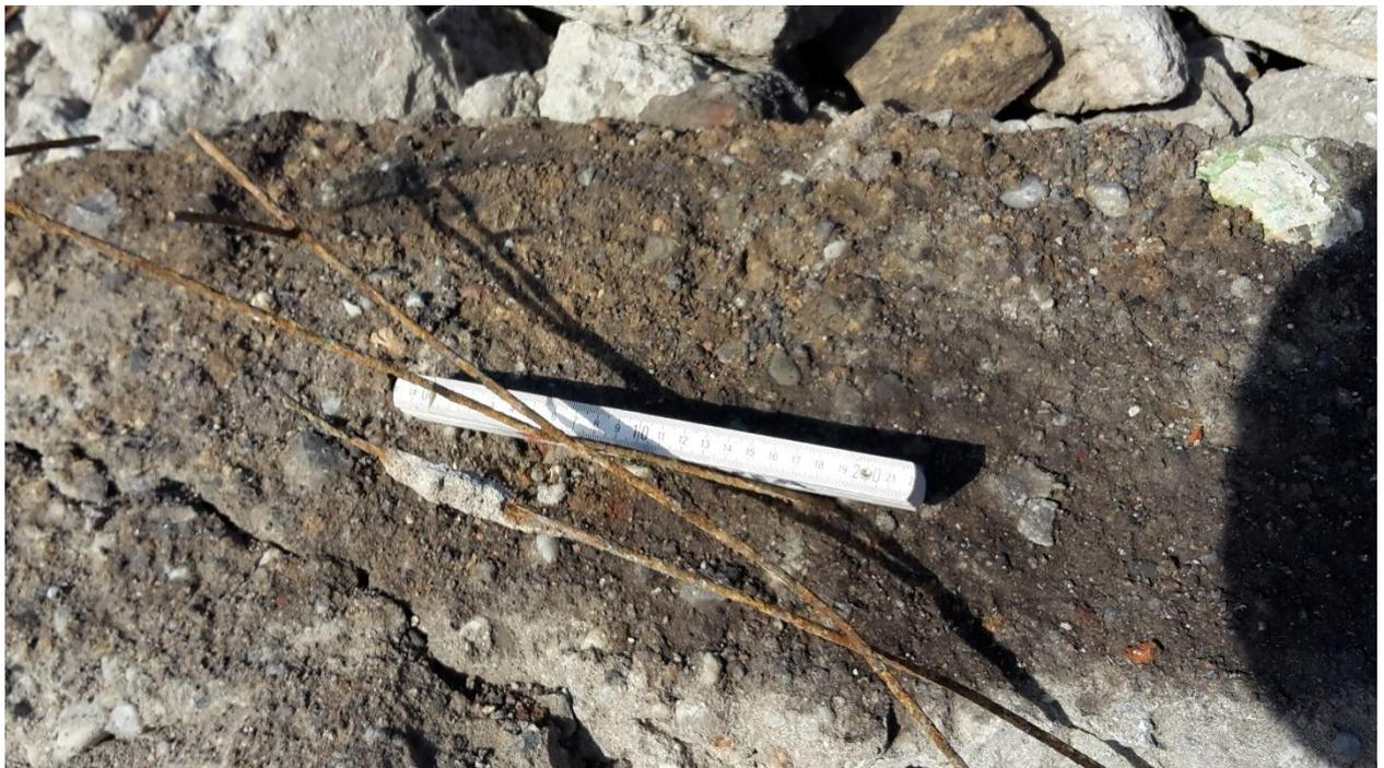
Abb.2 Detail: Verölte Oberfläche auf dem Betonaufbruch und Bewehrungsseisen.
