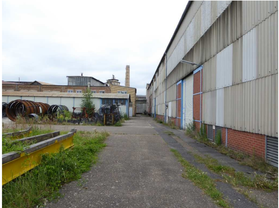
Foto 12: Fabrikgebäude und Lagerflächen
