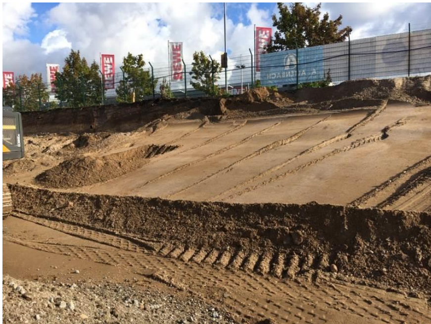
Abb. 3 Blick auf die gesicherte Baugrube nach Ausbau der Betonwannen an der Scheffelstraße.
